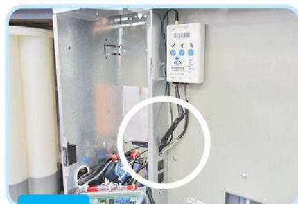
фото 6 Подключите кабели и антенну к модему. Кабели протяните в отверстие из-под разъема DI9.
